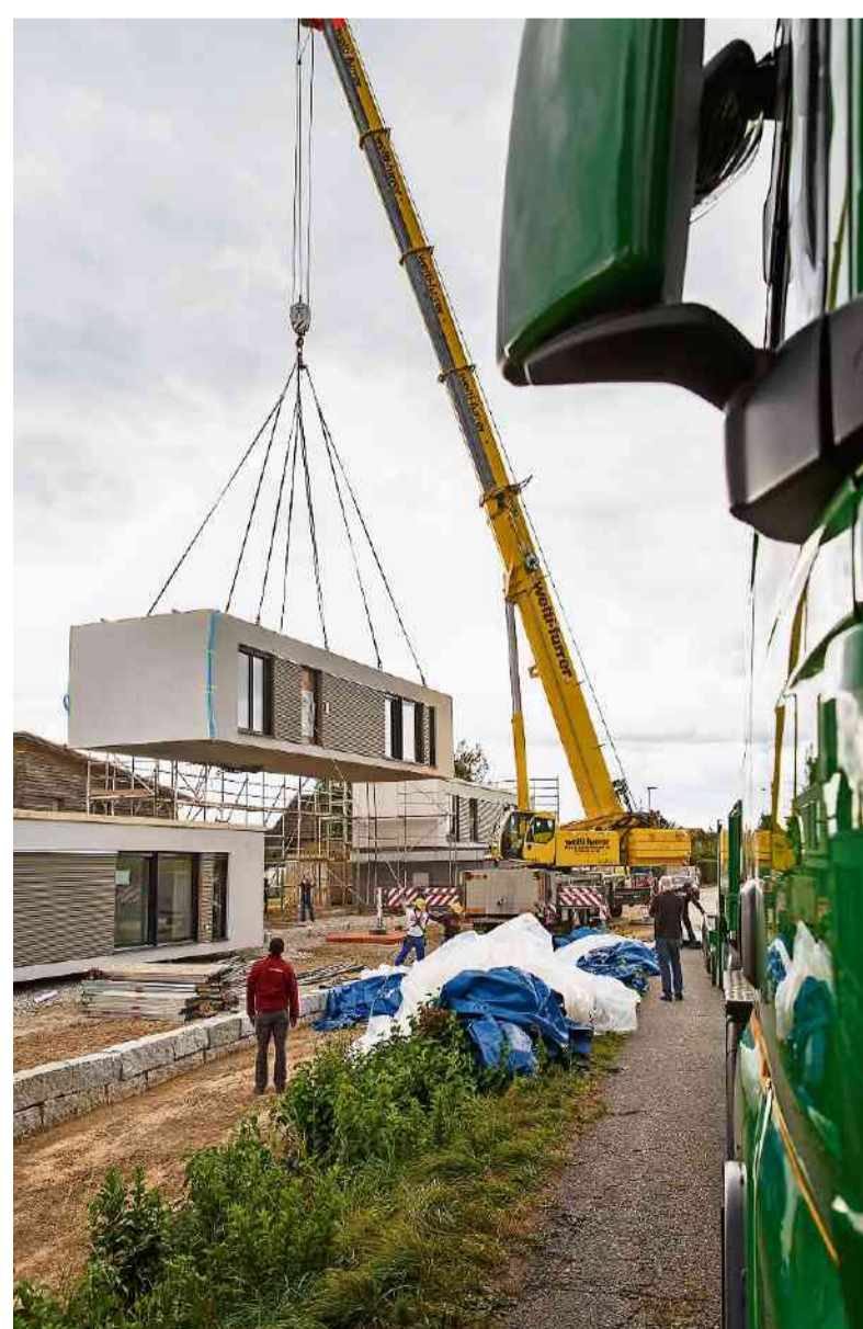
Vier vorgefertigte Kleinhäuser werden in Deitingen mit dem Pneukran auf einer Restparzelle aufgebaut.
